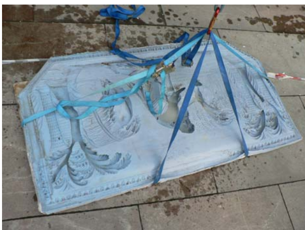
rekonstrukce reliéfů letohrádku královny Anny na Pražském hradě, (použitý silikon MM922+CAT B5 i R5+MMTA2)
